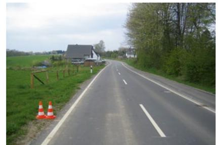
**BILD:** In Versuchen ergab sich eine Erhöhung der Bremsverzögerung um  $0,5 \text{ m/s}^2$  13 Monate nach der neuen Asphaltierung
